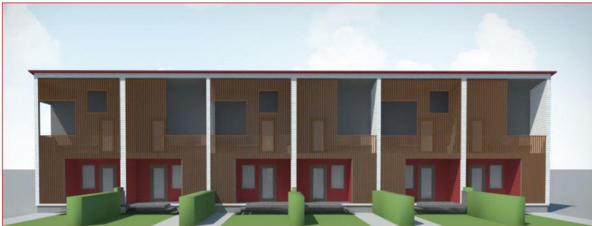
Abb. 3 : Wohn-Module mit Terrassen und Balkonen sowie „traditioneller“ Gartennutzung
